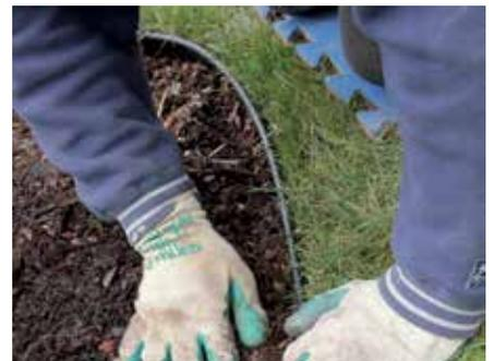
Wickeln Sie die B-Edge Smart Rolle ab und beschweren Sie die Enden mit Gewichten. Dadurch wird der Kunststoff wieder geradegebogen. Je wärmer dabei die Temperaturen sind, desto besser.
